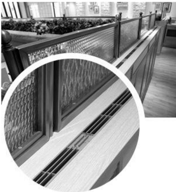
これにより、喫煙席エリアには常にクリーンな空気が循環し、非喫煙席エリアへの煙やニオイ漏れが防止されています。
